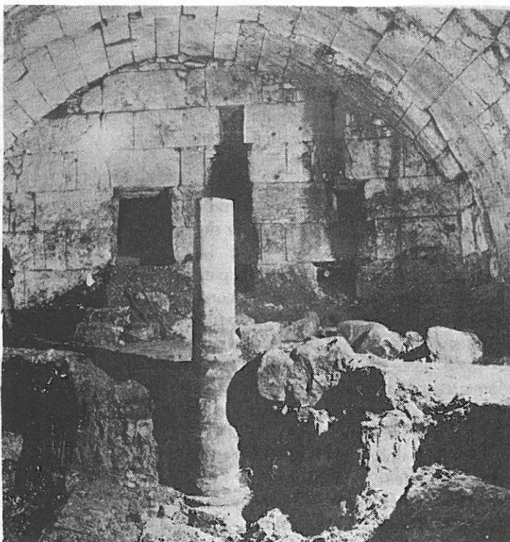
Vue partielle de la "Salle hasmonéenne", lors des travaux de dégagement.
